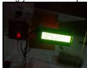
Gambar 12. Pengujian Kondisi Pompa Air Pelan
