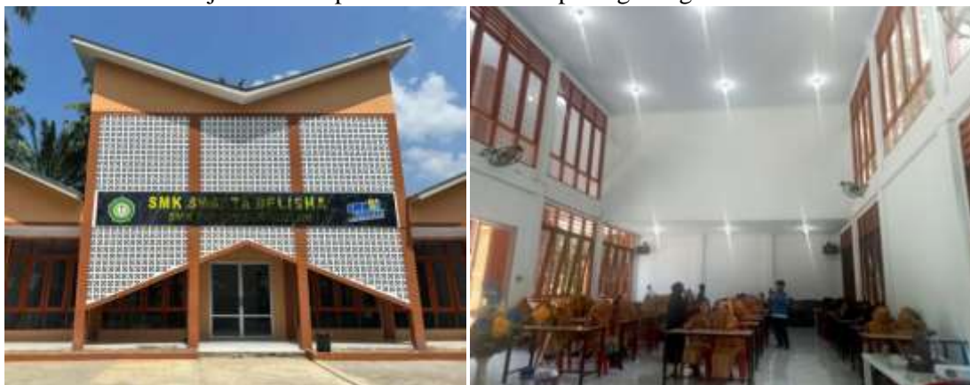
Gambar 2. Gedung Aula SMK Swasta Delisha
